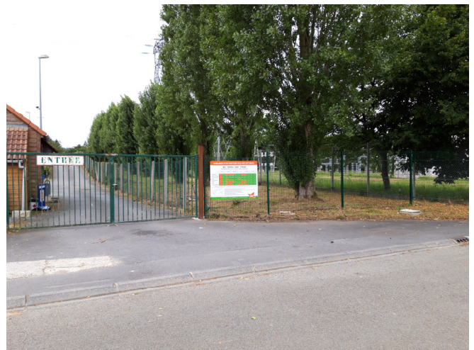
Déchèterie à Orbec
