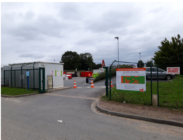
Déchèterie à Hermival-les-Vaux
