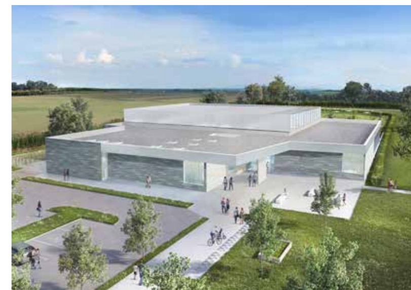
Centre aquatique, Saint-Pierre-en-Auge
