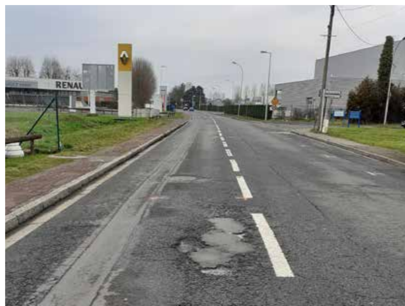
Travaux Rue Paul Cornu
